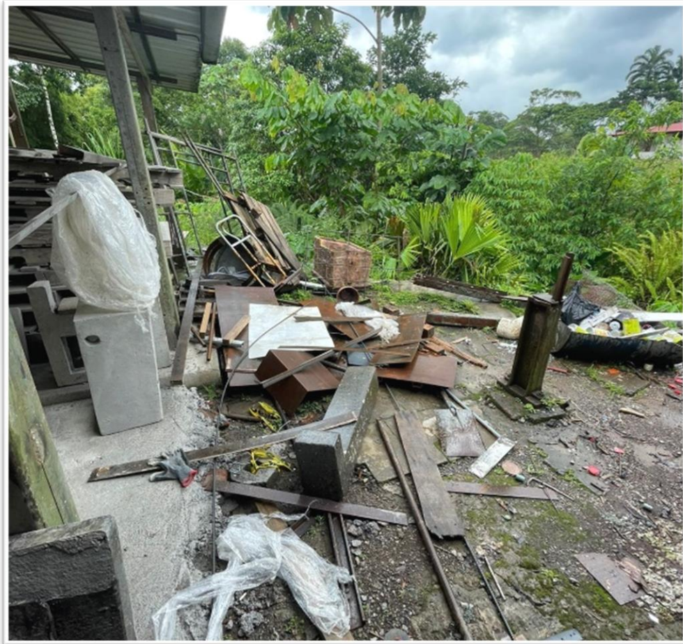
Figura 24. Desechos de suelda y cortes.
