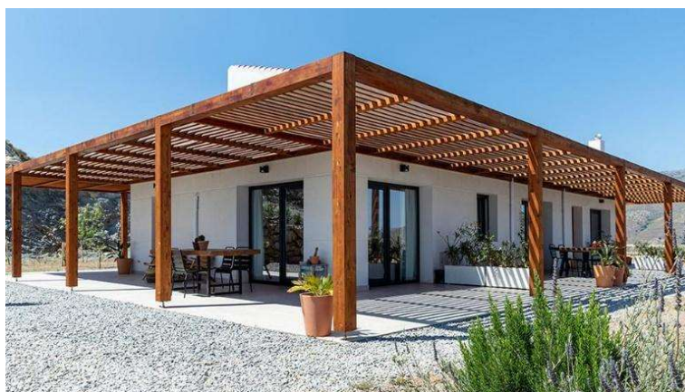
Figura 3. Pérgola de madera [6]
