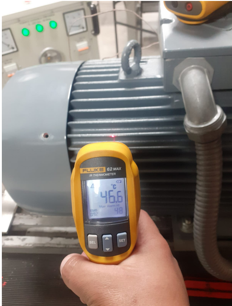
Figura 47: Tomas de temperatura sensor infrarrojo FLUKE
