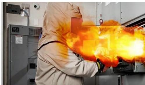
Figura 3. Arco Eléctrico generado por una maniobra de CCM [2]
