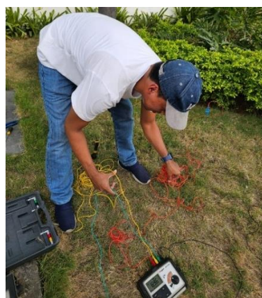
Figura 40. Medición de la resistividad del terreno.
