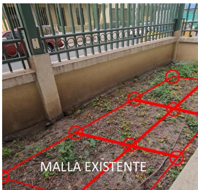
Figura 34. Ubicación del segundo sistema de puesta existente.
