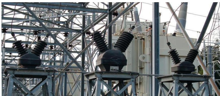
Figura 6. Transformador de potencial
