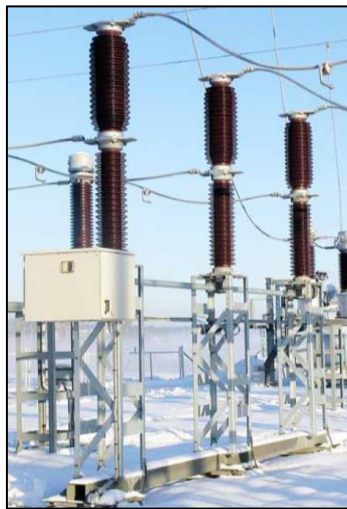
Figura 20.- Interruptor de Potencia
