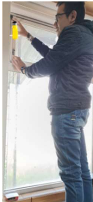
Figura 4.4.3.2 Instalación de Raspberry
