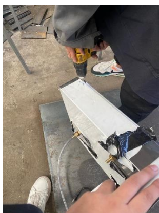
Figura 48. Perforación de huecos para armar la puerta.
