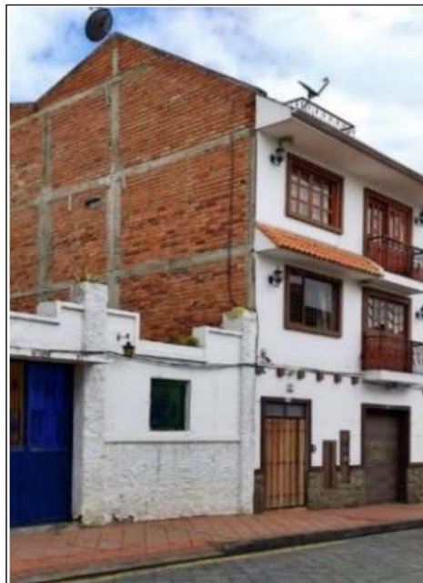
Mampostería de ladrillo confinado
