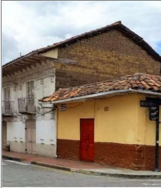
Mampostería de adobe (no confinado)
