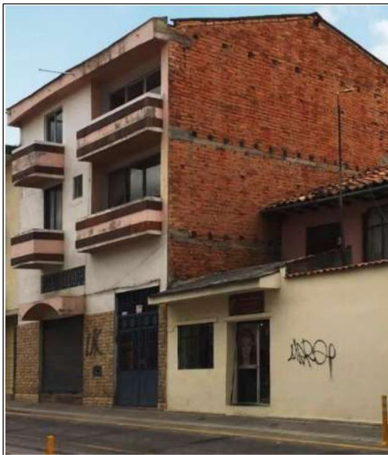
Mampostería de ladrillo con vigas de atado
