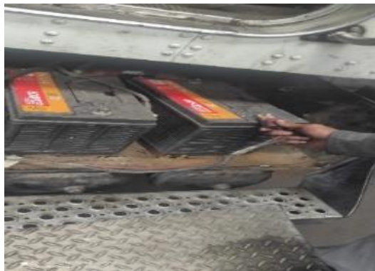
Figura 4.18: Desconexión de cables de alimentación
