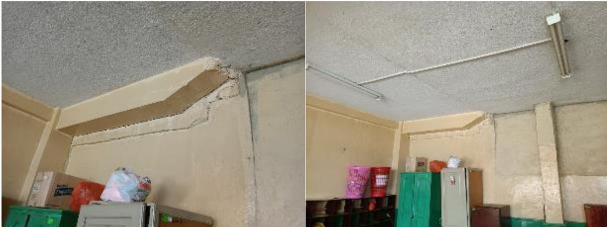
*Nota.* Losa apoyada sobre parte de la viga peraltada del bloque 2. Elaborado por: El autor.
