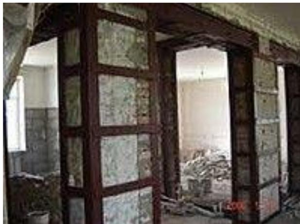
*Nota.* En la figura se muestra el acero de refuerzo colocado en columnas, las cuales se anclan a la losa. Fuente: (ek4, 2021)
