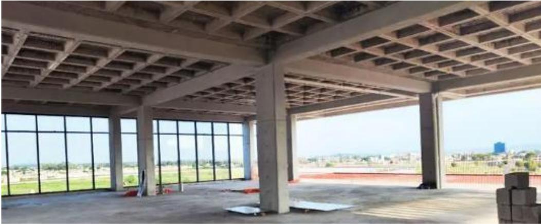
*Nota.* La imagen muestra una losa reticular con vigas peraltadas. Fuente: (Maxacero, 2023)
