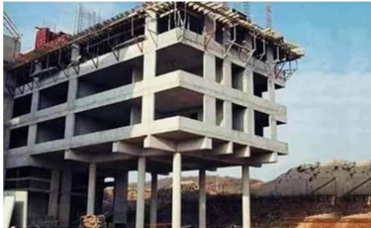
*Nota.* Se puede apreciar en la figura irregularidad vertical de piso blando, producto de la reducción de la rigidez en el primer nivel. Fuente: (CYPE, 2020)
