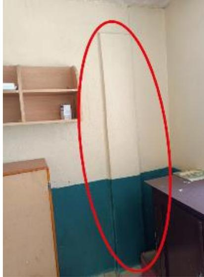
*Nota.* Se puede apreciar que la columna que viene desde el nivel inferior no llega a conectar con la losa de techo. Elaborado por: El autor.
