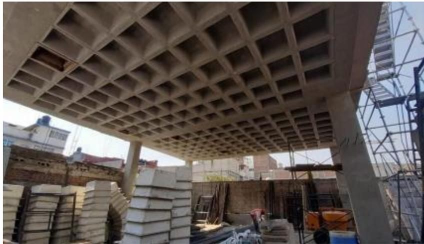
*Nota.* La imagen muestra una losa reticular con vigas embebidas. Fuente: (OCRE, 2023)
