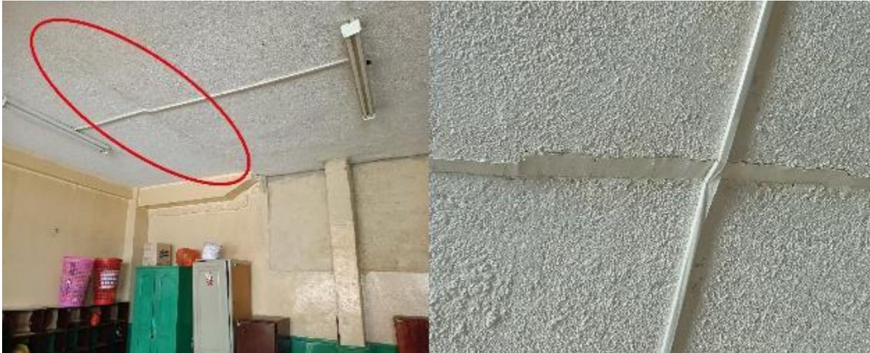
*Nota.* La fisura se presenta y se extiende a lo largo del eje ortogonal de la losa del bloque 2.
