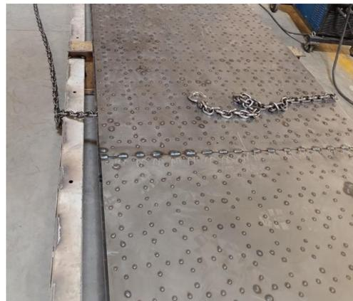
**Figura 14.** Unión de módulos en el vano de los apoyos.
