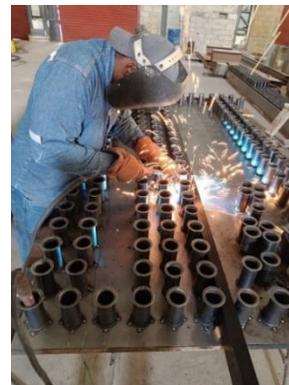
**Figura 5.** Fabricación de probetas (diafragmas rígidos).
