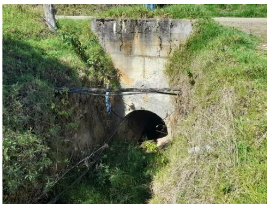
Figura 55. Imagen de estudio de alcantarilla en la vía
