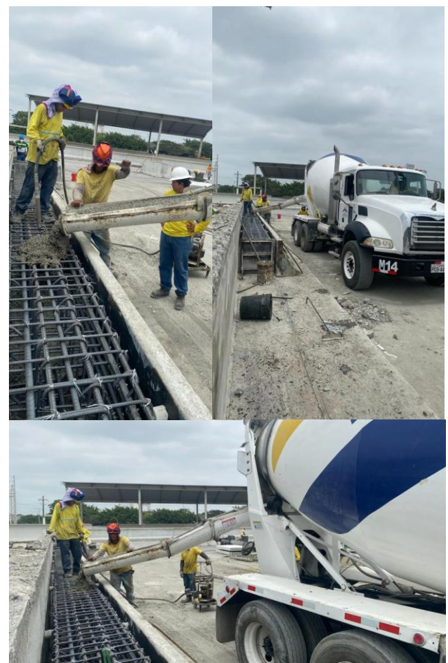
Figura 30. Vista de la fundición del pilote.
