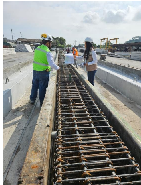
Figura 29. Vista de la armadura de pilotes figurada previo a la fundición del pilote.
