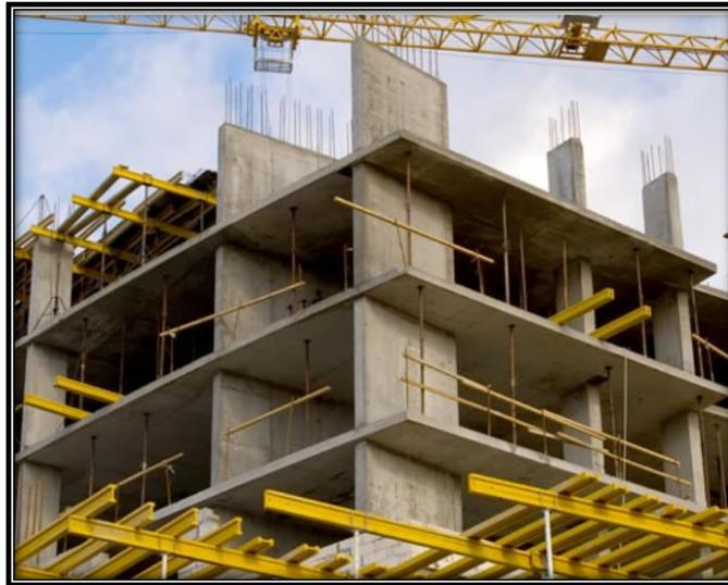
*Nota.* En la figura se aprecia muros estructurales a lo largo de toda la altura de la estructura además de vigas y columnas de los pórticos. Fuente: Muñoz (2015).
