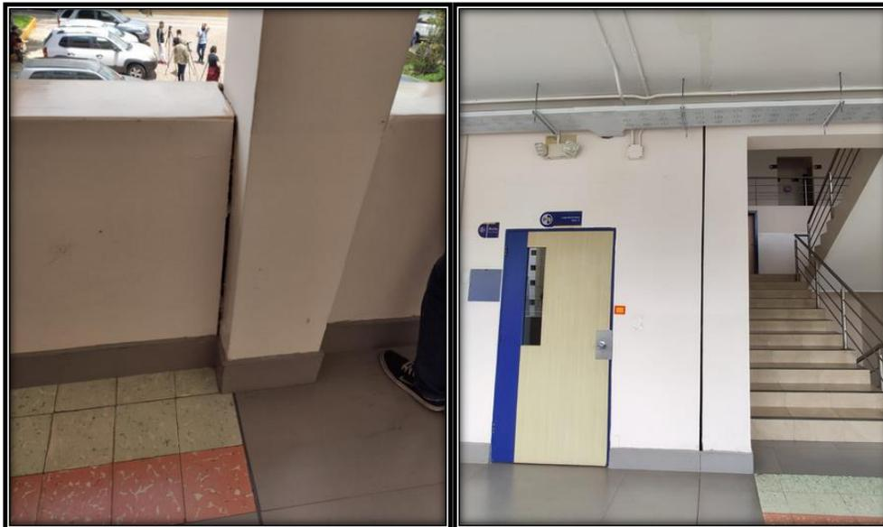
*Nota.* En la imagen se observa la junta que delimita la edificación con la parte más nueva del “Bloque A” en el lado norte. Fuente: Los Autores.
