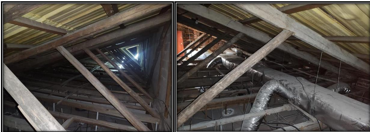
*Nota.* En las imágenes se aprecia el techo del cuarto piso, lugar que es utilizado como laboratorio de psicología. Se encuentra conformado por estructura de madera, el piso corresponde al nivel N+ 14.15 m. Fuente: Los Autores.
