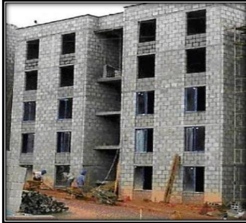
*Nota.* En la figura se aprecia un edificio que tiene mampostería confinada en su estructura.
