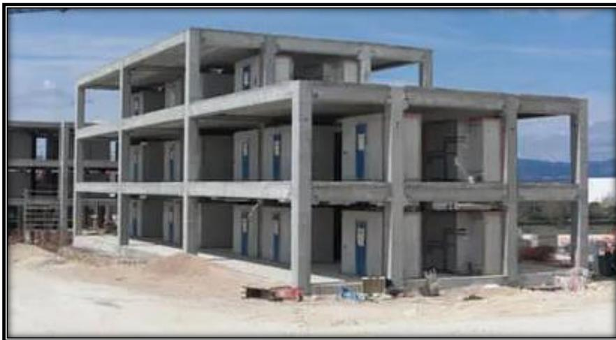
*Nota.* En la figura se puede notar los elementos estructurales como vigas y columnas que componen los pórticos. Fuente: Pujol (s.f.).
