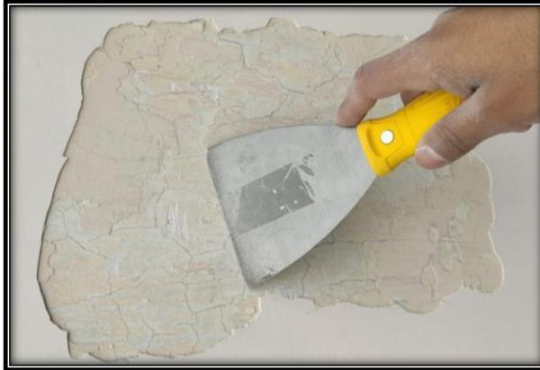
*Nota.* En la imagen se observa una de las capas que se retiró para la ejecución del ensayo con el esclerómetro. Fuente: Los Autores.
