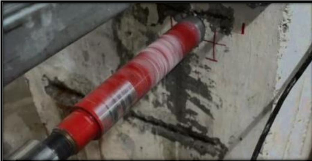
*Nota.* Intervención en un elemento estructural para la obtención de una muestra cilíndrica de hormigón. Fuente: Cotecno (2023).
