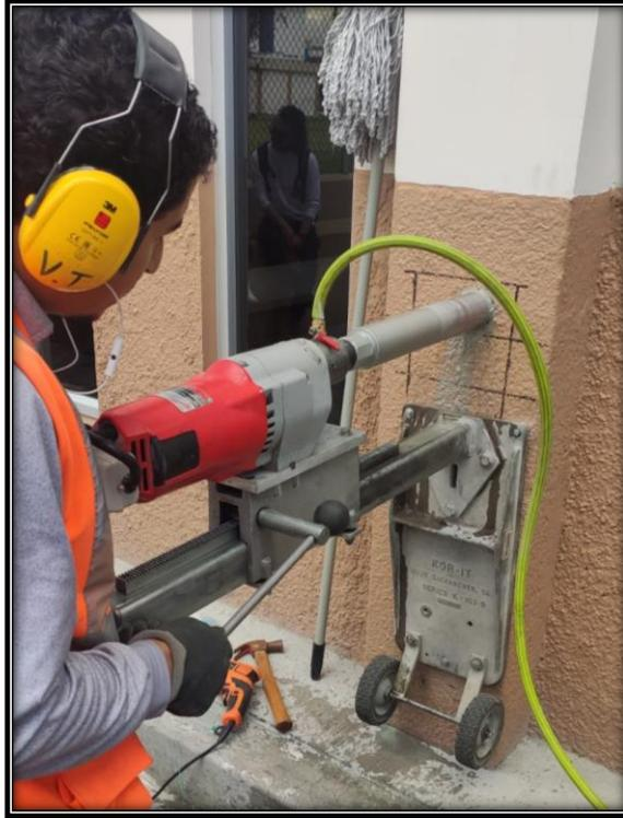
*Nota.* En la imagen se puede apreciar cómo queda asegurada la extractora de núcleos a una columna. Fuente: Los Autores.
