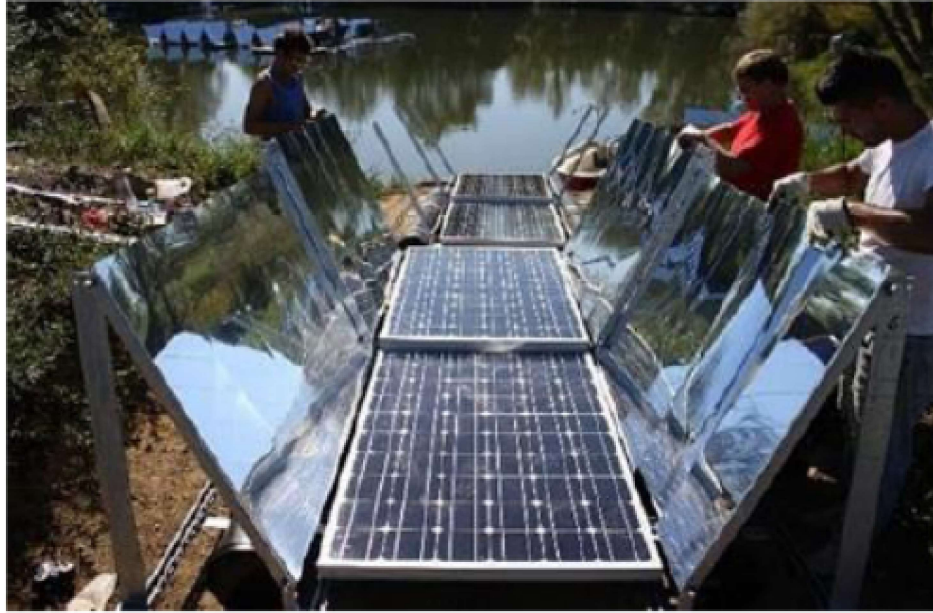
Figura 1.2: Montaje de espejos y paneles por el grupo Scintec [1].
