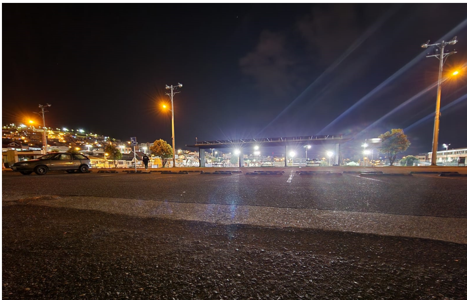
Figura 4.27: Montaje de luminarias tipo sodio.[Fuente: Autores.]
