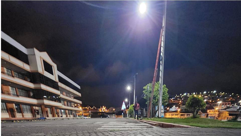
Figura 4.28: Montaje de luminarias tipo LED.[Fuente: Autores.]
