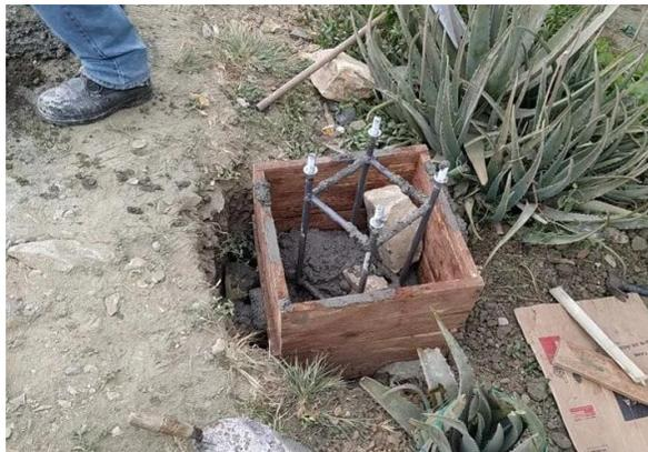
**Figura 27:** Instalación de la varilla metálica
