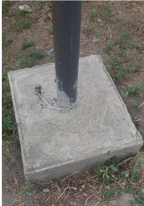
**Figura 25:** Base de la estructura metálica
