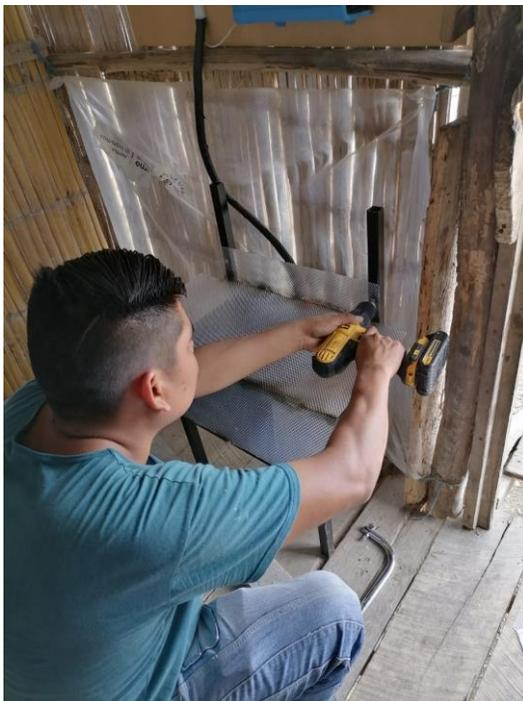
**Figura 35:** Montaje de la estructura metálica
