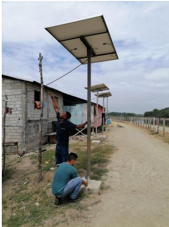
**Figura 28:** Soporte del panel solar
