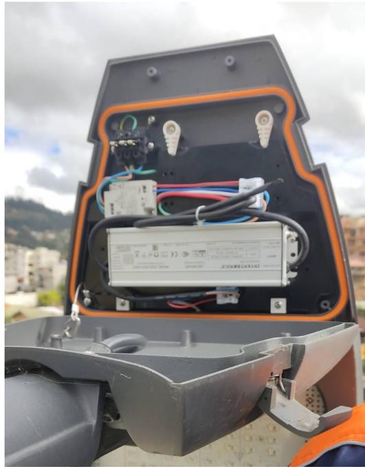
Figura 2.2: Vista interna de la luminaria HYDD-LED10/240W.
