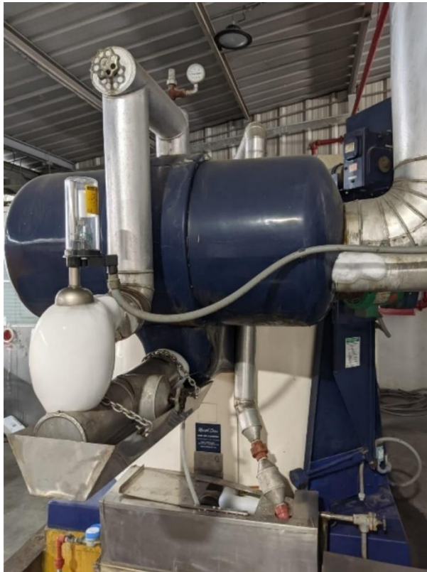
Fig. 6: Instalación de bandeja recolectora de condensado
