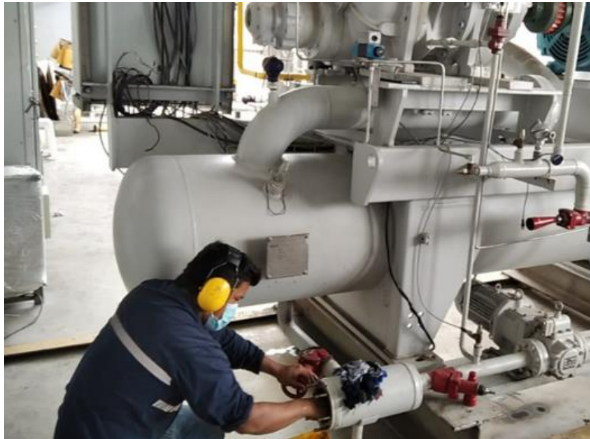
Fig. 22: Antes de la implementación del filtro en paralelo.
