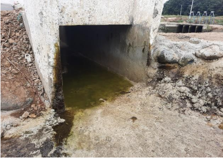
Figura 13.- Ducto cajón en salida de estación de bombeo
