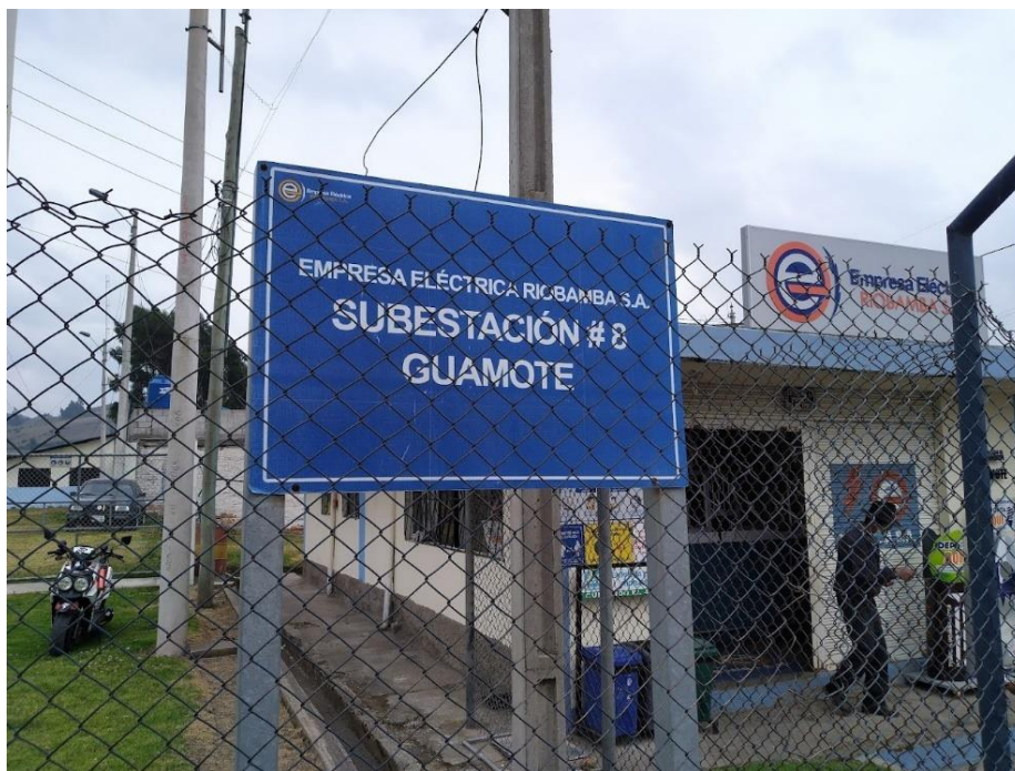
Figura 71. Lugar donde se instalará el filtro activo.
