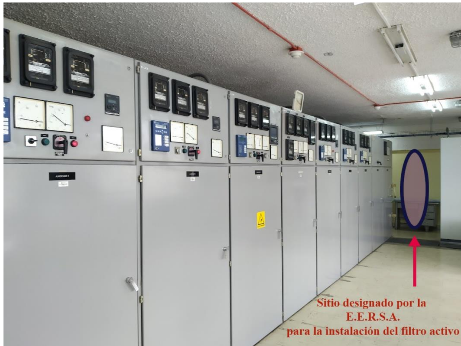
Figura 72. Sitio designado para la futura instalación del filtro activo.
