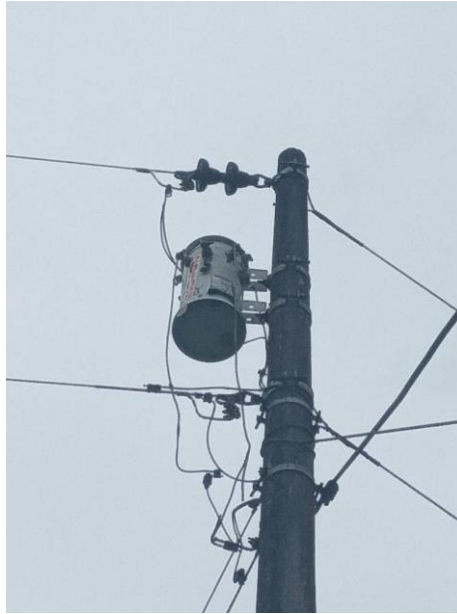
Figura 13 Poste existente Fuente: Autor
