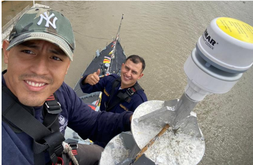
Figura 3. Colocación de Antena Airmar 220 WX.
