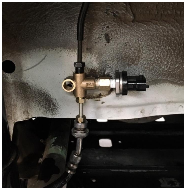
Figura 11 Acople y sensor de presión instalado en el sistema
