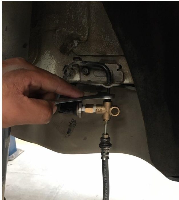
Figura 10 Instalación de acoples
