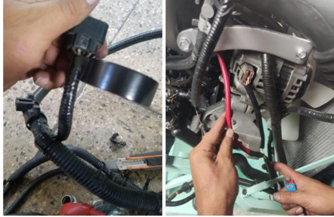
Figura 2.12 Reparación y aislamiento de cables.
