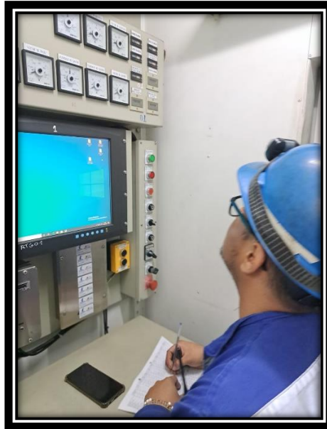
Figura 29 Toma de valores energéticos de forma manual por técnicos de Contecon
