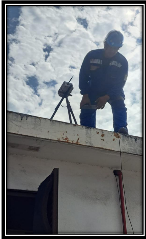
Figura 23 Instalación del módulo Xbee en el cuarto Reffer 2 alfa
