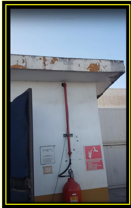
Figura 17 Cuarto de transformadores y factores de potencia
