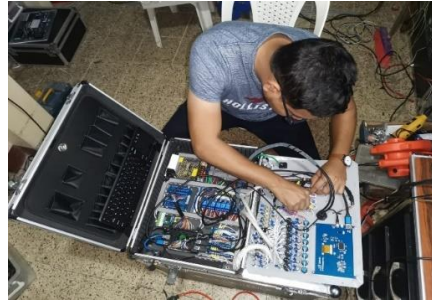
Figura 19. Conexiones módulo entrenamiento
