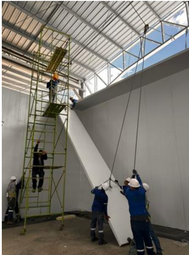
Figura 3.8 Elevación de paneles a mano
