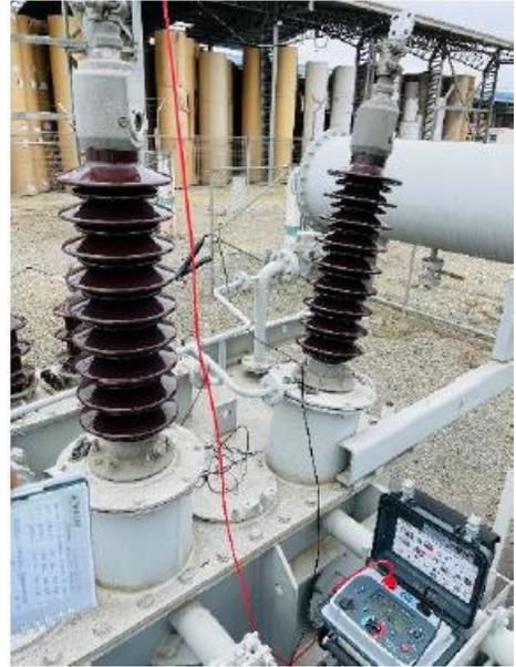
Figura 8 Limpieza bushing 69KV
