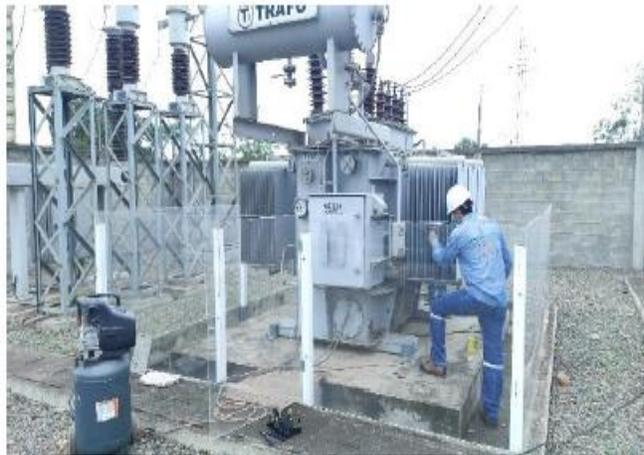
**Figura 5 Limpieza transformador de potencia**
