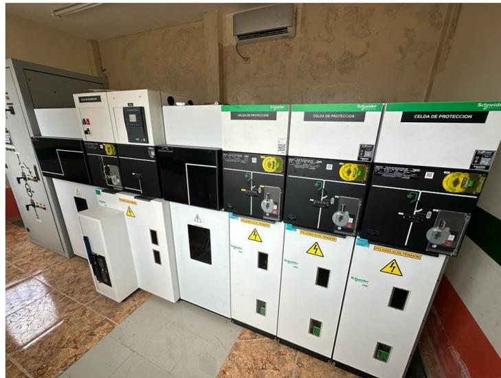
**Figura 13 Celdas 24KV**
