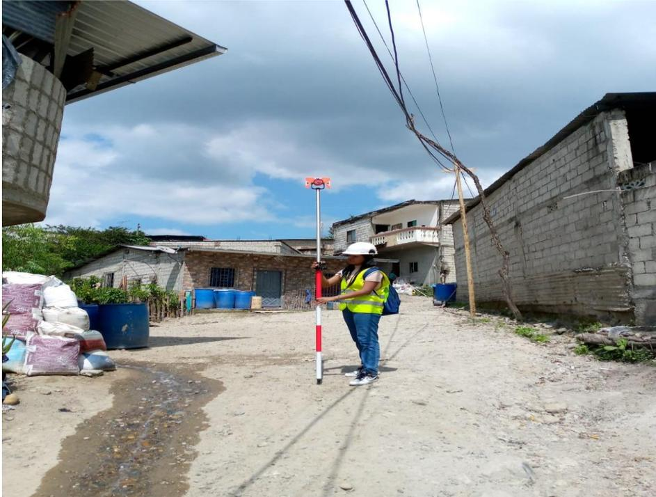
*Ilustración 21 Obteniendo punto con el prisma topográfico.*
