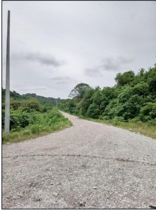
Ilustración 4 Estado Actual de la Vía
