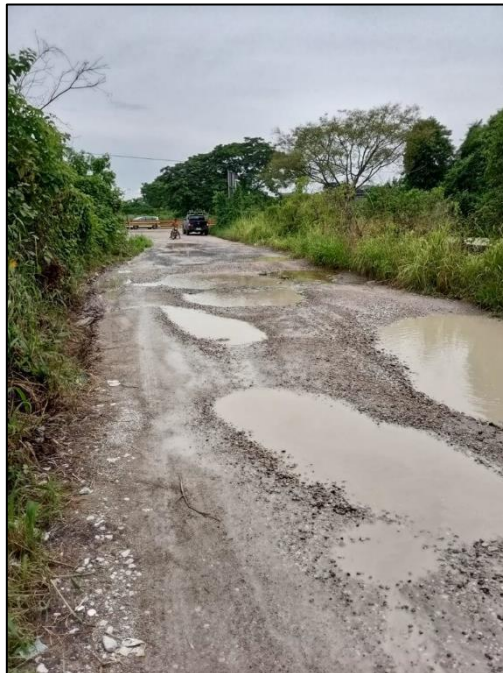
Ilustración 3 Estado Actual de la Vía
