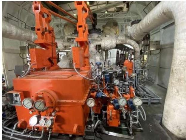
**Nota:** Fotografía del bloque del regulador en donde se puede observar los componentes principales del sistema de regulación que controlan el flujo de vapor hacia la turbina.
