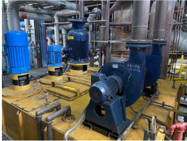
**Nota:** Fotografía de la configuración de las bombas que comandan el sistema oleo hidráulico de la central térmica Esmeraldas I.
