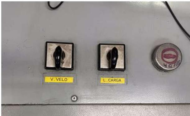
**Nota:** Fotografía de los pulsadores del variador de velocidad y limitador de carga, ambos cuentan con dos posiciones que equivalen a los pulsos para el control de carga desde el tablero de la sala de control.
