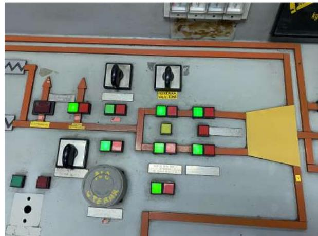
**Nota:** Fotografía del tablero de mando de la sala de operaciones en las que se puede observar el diagrama de la turbina para su control mediante pulsadores.
