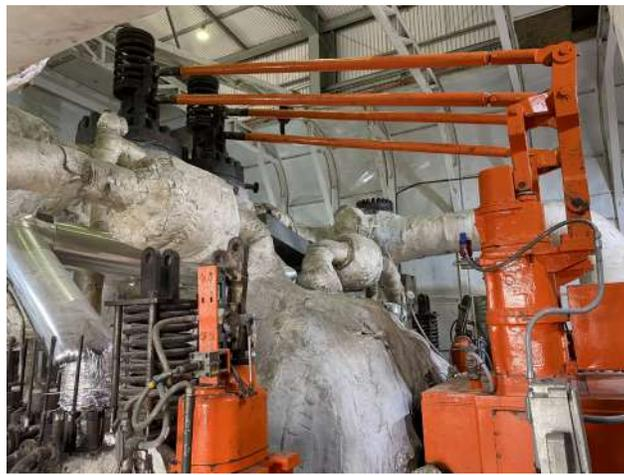
**Nota:** Fotografía en la que se puede observar las dos válvulas de interceptación del sistema de regulación.
