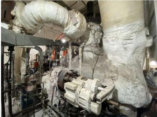
**Nota:** Fotografía de la válvula del lado derecho, lugar donde se pretende colocar los sensores para su control (existe dos, una del lado derecho y una del lado izquierdo, en ambas se aplica).
