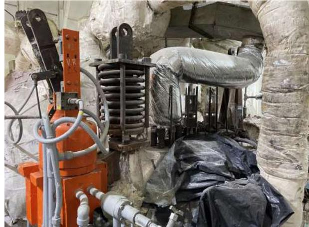
**Nota:** Fotografía en la que se puede observar el desgaste en los actuadores, y la correcta atención con ellos, lo cual repercute en la apertura correcta de las válvulas.
