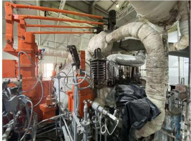
**Nota:** Fotografía de las válvulas de regulados del lado derecho, lugar donde se pretende colocar los sensores para su control (existe seis, tres del lado derecho y tres del lado izquierdo, en ambos lados se aplica).
