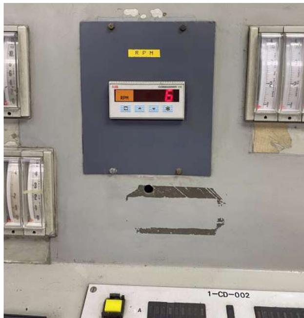
**Nota:** Fotografía del medidor de RPM para el control de la velocidad de la turbina.
