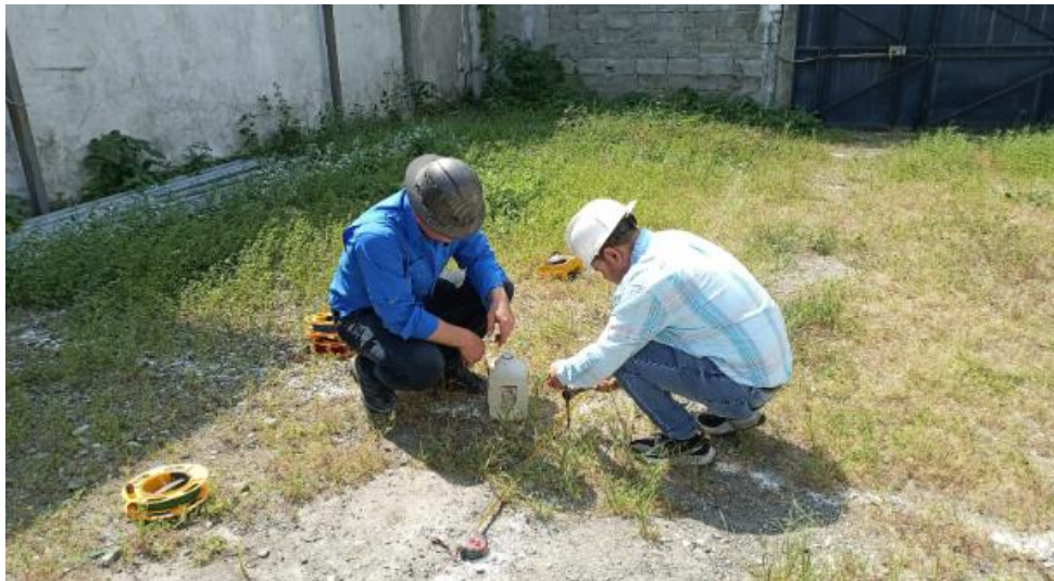
Figura 32 Procedimiento de las mediciones de malla de puesta a tierra
