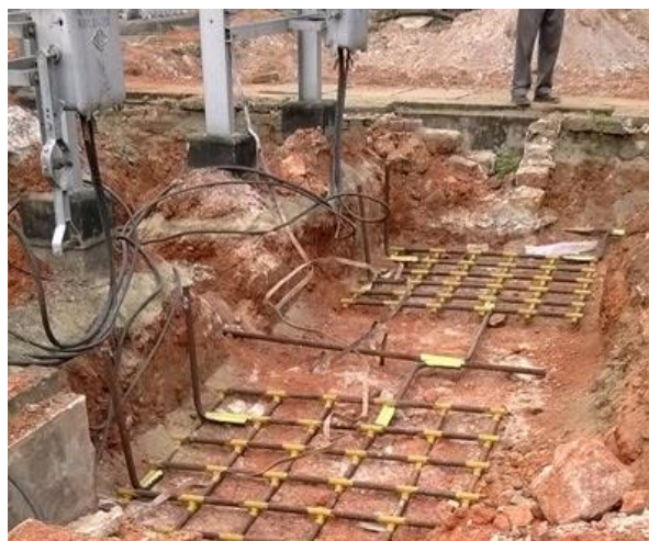
Figura 12 Malla de puesta a tierra [22]
