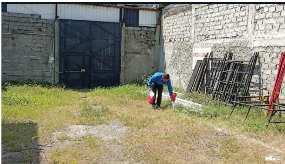
Figura 30 Mediciones en el área destinada a la instalación de malla a tierra
