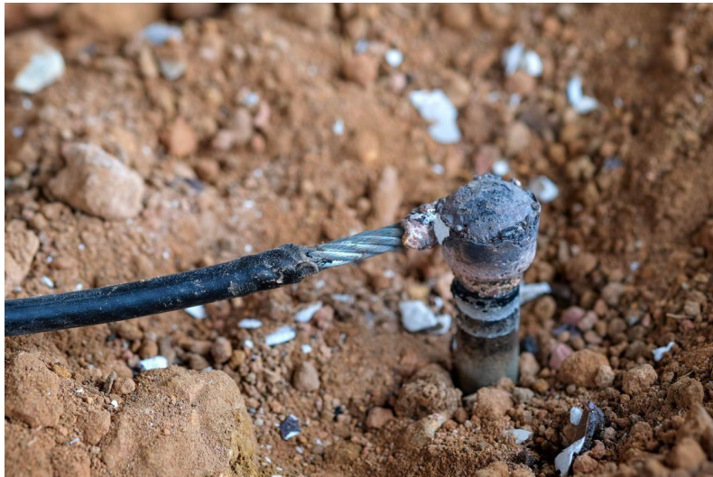
Figura 24 Conductor a tierra soldado a una varilla de cobre
