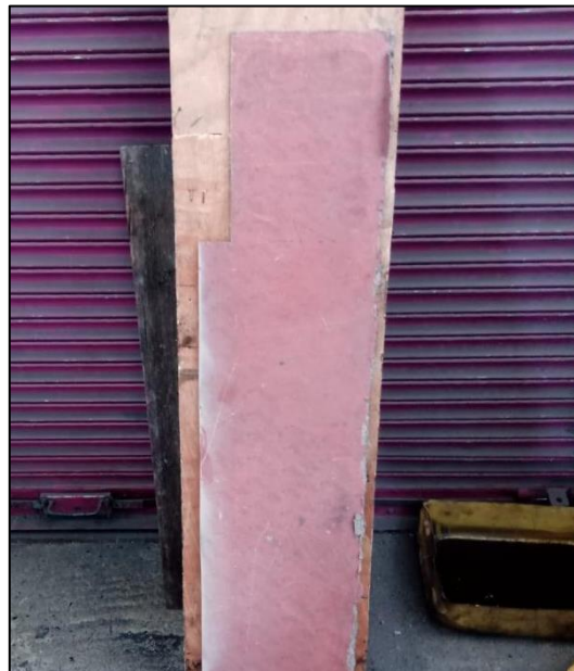
Fig. 47 Aislante térmico (Amianto)
