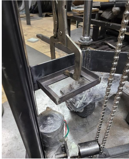
Figura 52 Sujeción post soldadura. El autor.
