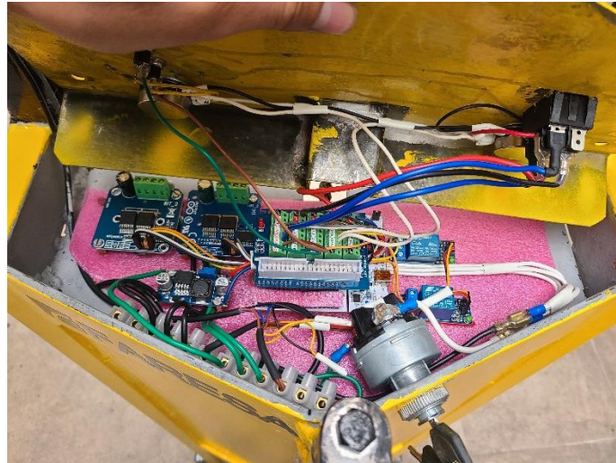
Figura 57 Gabinete de alojamiento de tarjetas de control. El autor.
