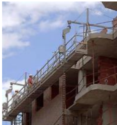
Figura 11. Sistema de andamiaje colgante en obra civil [18].
