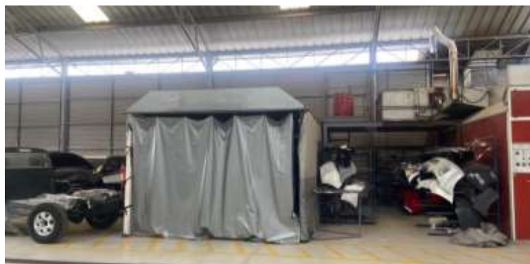
Figura 23. Falta de ventilación adecuada
