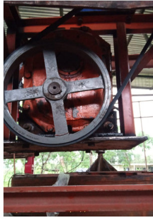
Figura 85. Sistema de poleas colocado [8]
