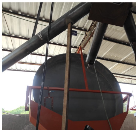
Figura 57. Instalación de tolva dosificadora [11]
