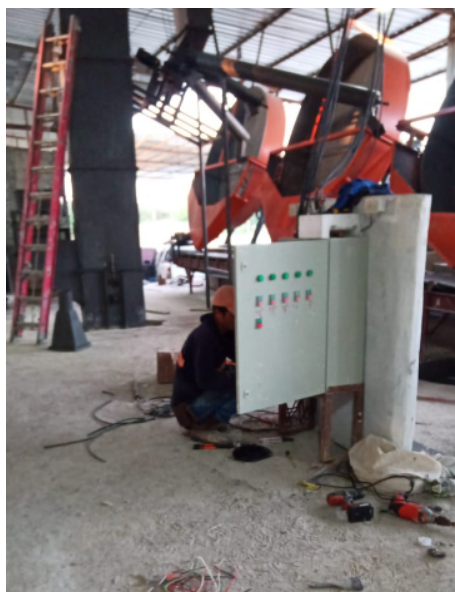
Figura 105. Reubicación tablero B [9]
