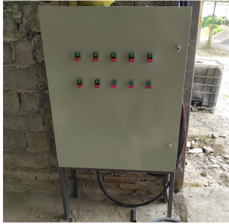
Figura 107. Instalación parcial tablero A [9]
