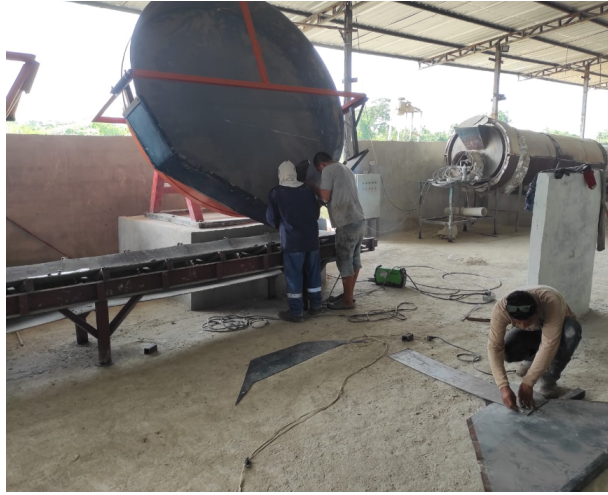
Figura 90. Banda de salida colocada [6]
