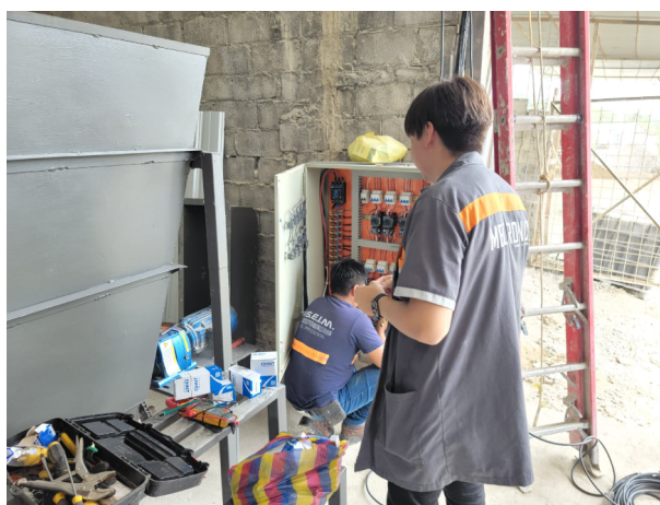
Figura 106. Implementación tablero A [9]
