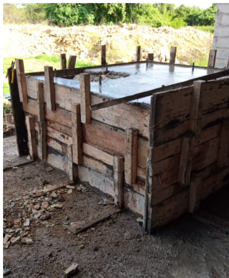
Figura 80. Construcción de base de concreto por parte de la empresa [8]
