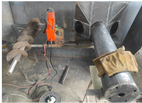
Figura 55. Acoplamiento de tubos para material [11]
