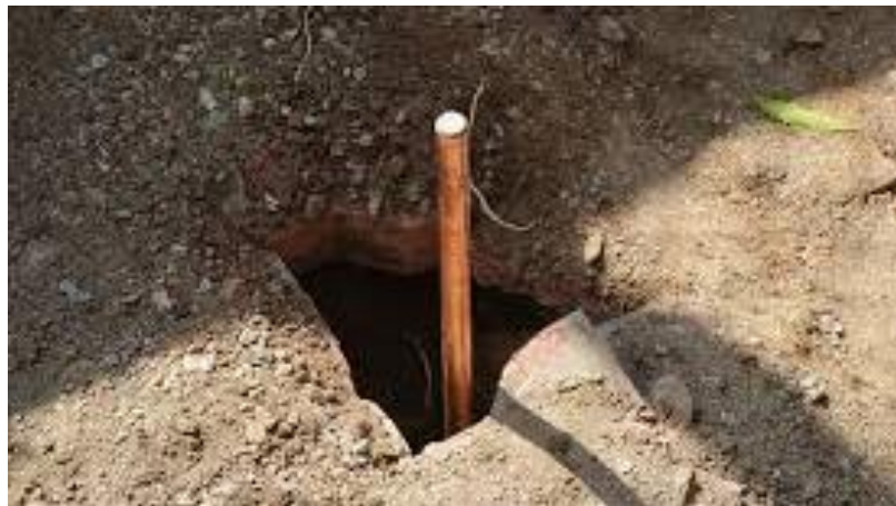
Figura13.- Posición correcta varilla de cobre.
