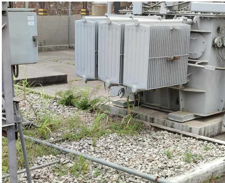
Figura 22.- Medición de resistencia en puntos de conexiones de puesta a tierra.
