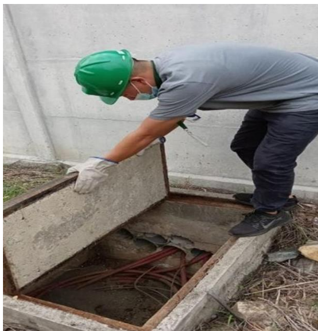
Figura 25.- Inspección de cajas de paso.
