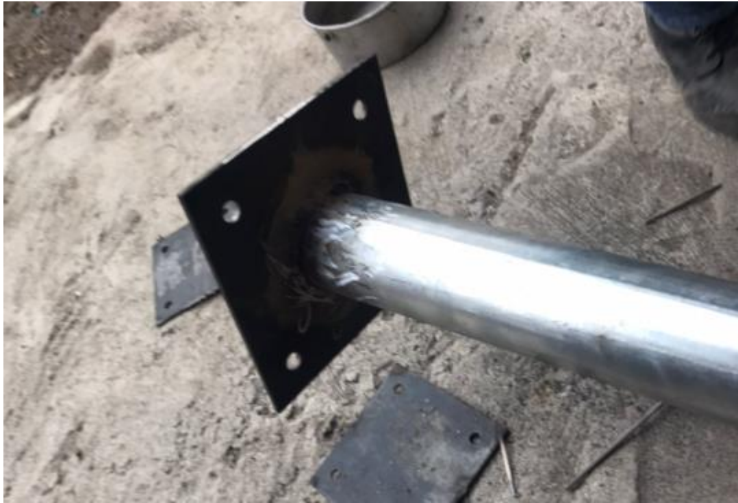
Figura 40. Base del poste en plancha de 5 mm
