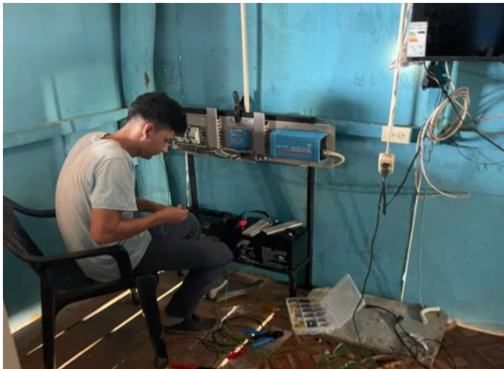
Figura 44. Apriete de terminales en la batería
