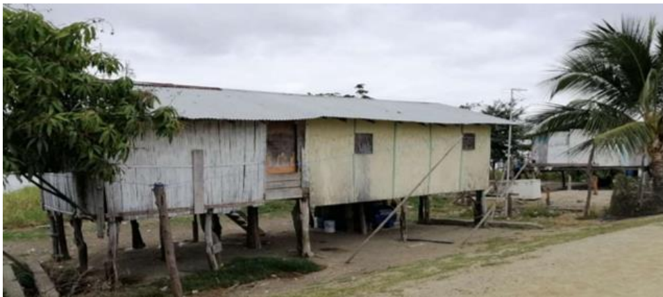
Figura 3. Vivienda donde se va a implementar el sistema fotovoltaico
