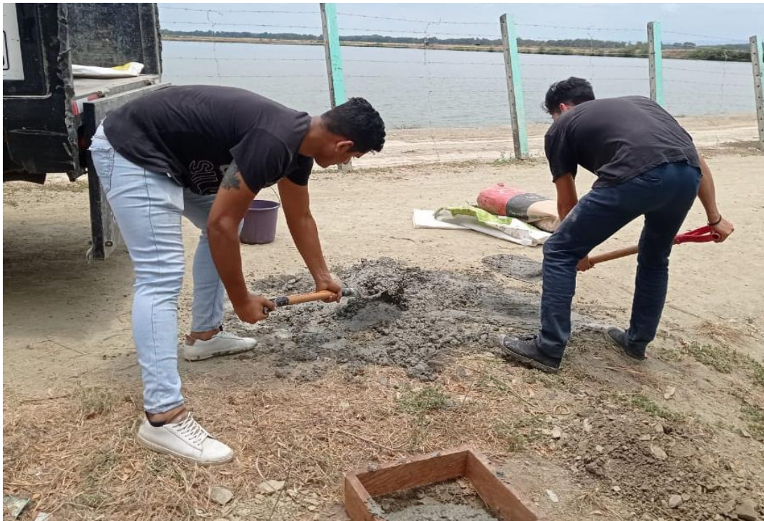
Figura 41. Fundición de la base del panel solar
