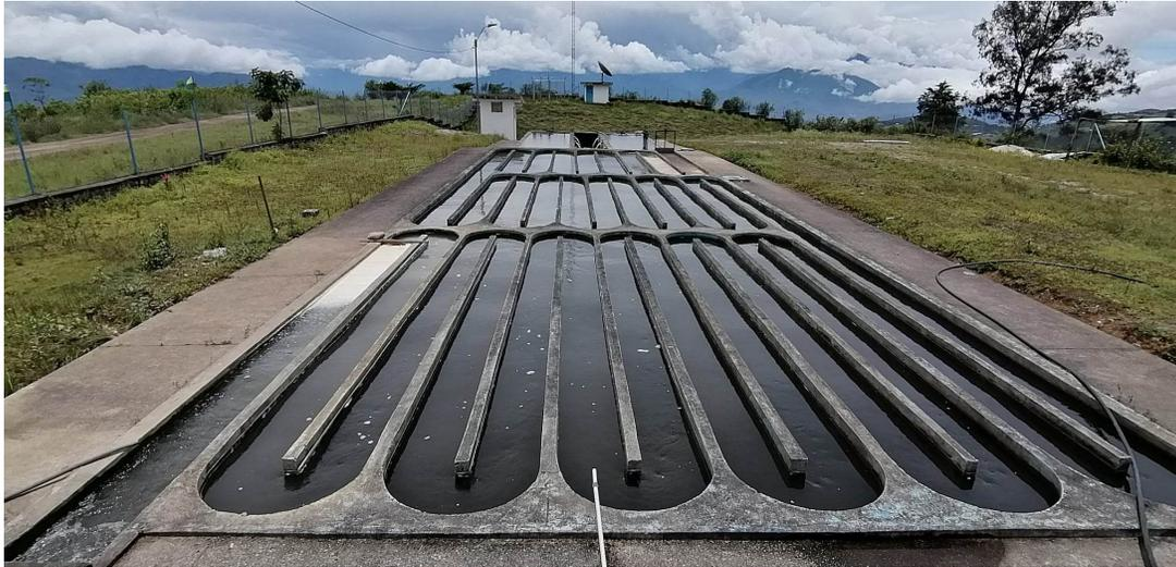
**Nota:** Proceso de tratamiento de agua potable, etapa de floculación. Aquí se aplica el sistema de floculación hidráulica
