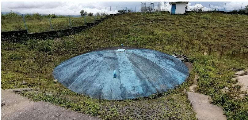
**Nota:** Tanque de almacenamiento de agua tratada con la capacidad de 500 mectros cúbicos.
