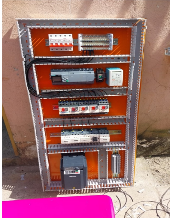
Figura 77. Armado de Tablero Eléctrico
