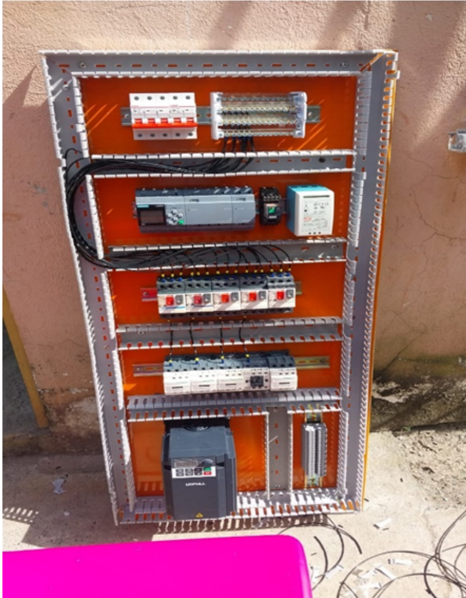
Figura 55. Armado de tablero 55
