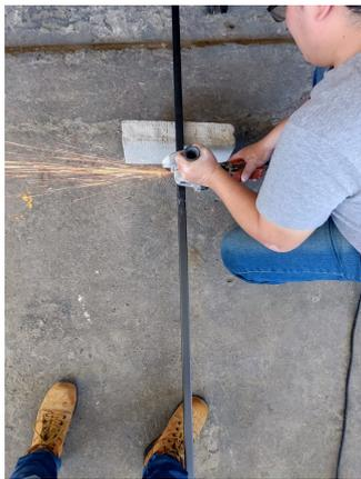
Figura 103. Corte de barras para la fabricación de la base, por A. Ochoa y X. López, 2023.
