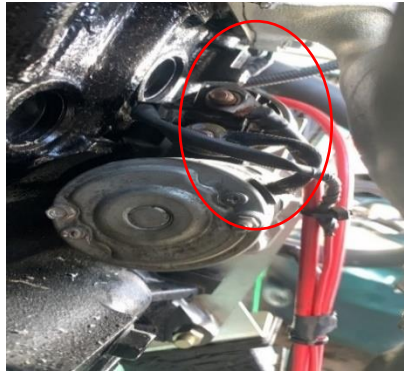
Ilustración 2.39: Enlace de los cables en su lugar correcto
