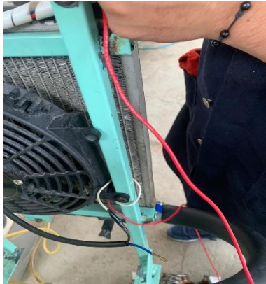
Ilustración 2.29: Radiador y ventilador corregido
