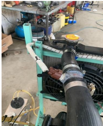
Ilustración 2.28: Cañerías de agua nuevas
