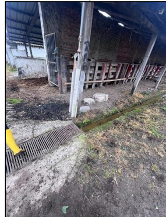
Nota. Canales de desagüe desde los establos
