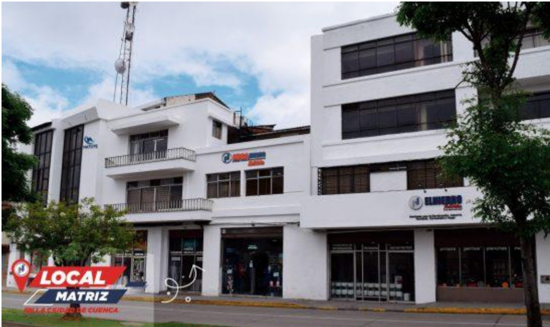
Figura 2: Almacén Principal Megahierro
