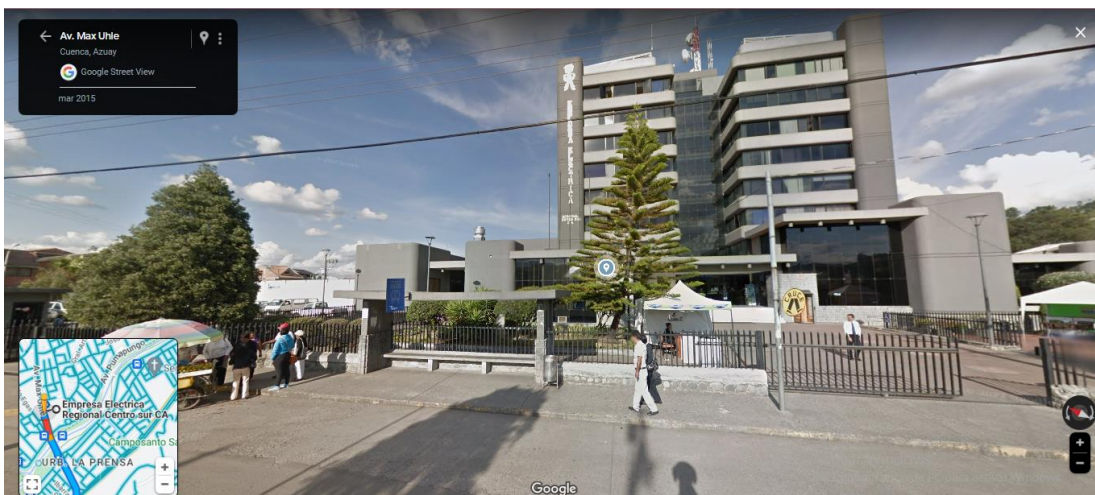
Figura 56. Empresa Eléctrica Centro sur.
