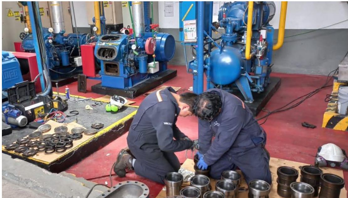
Figura 37. Limpieza y cambio de los filtros coalescentes
