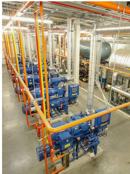
Figura 1. Sistema de refrigeración de amoníaco [4]
