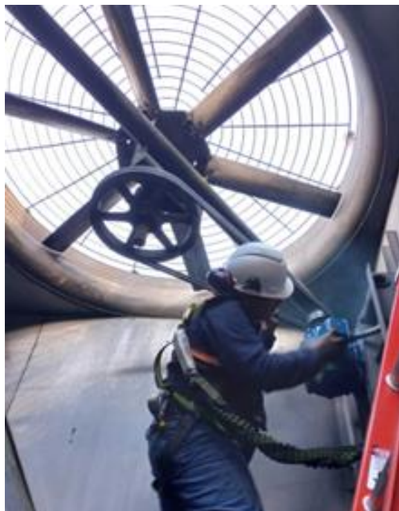
Figura 33. Mantenimiento de los motores del condensador
