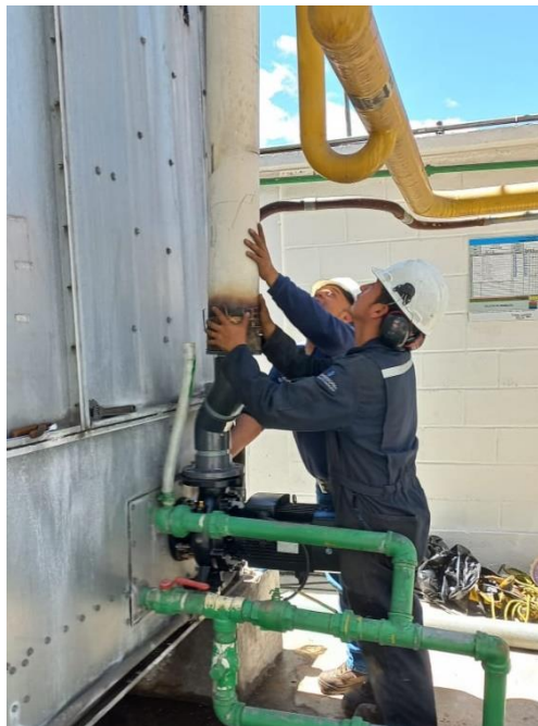
Figura 35. Montaje y acople de la tubería en la bomba del condensador
