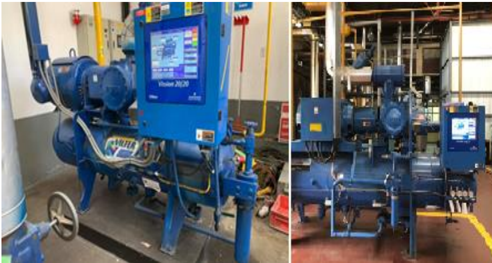
Figura 27. Compresor de válvula deslizante
