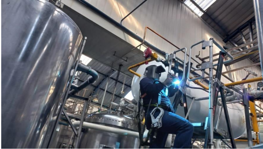
Figura 32. Trabajo de Soldadura en la tubería (cambio de válvula solenoide)
