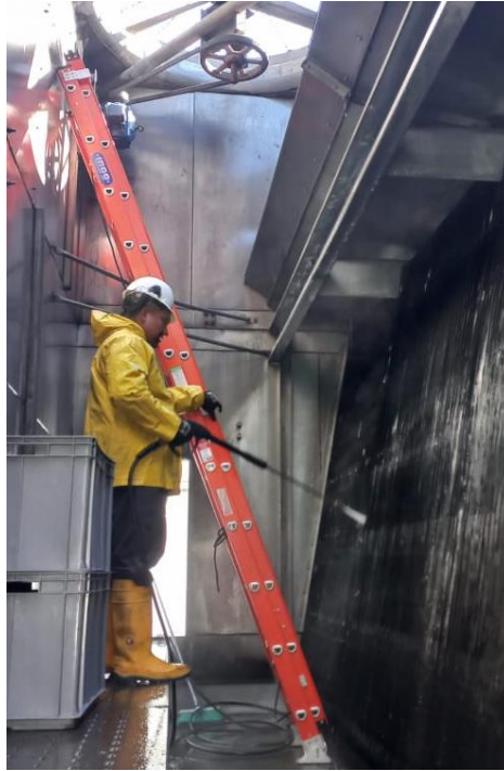
Figura 34. Mantenimiento de limpieza de las bandas de filtro de agua del condensador
