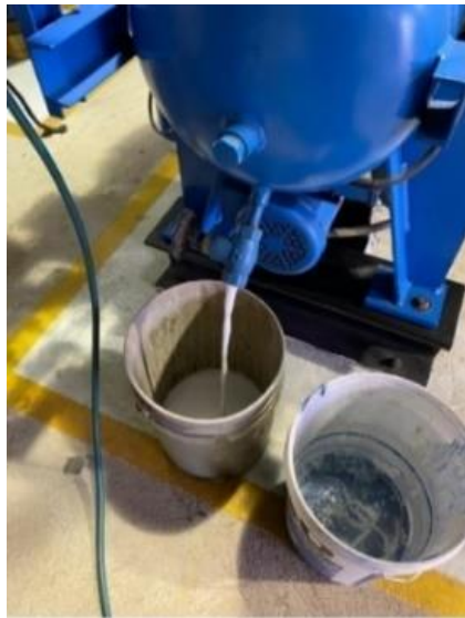
Figura 8. Vaciado de compresor reduciendo la humedad
