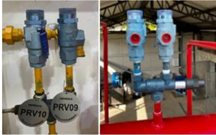
Figura 19. Inspección por giro en dirección opuesta
