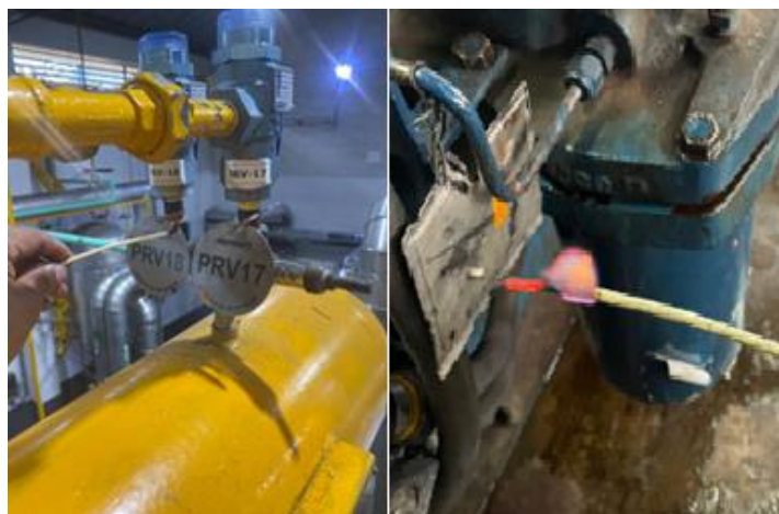
Figura 24. Inspección de fugas utilizando mechas de azufre para verificación de amoníaco
