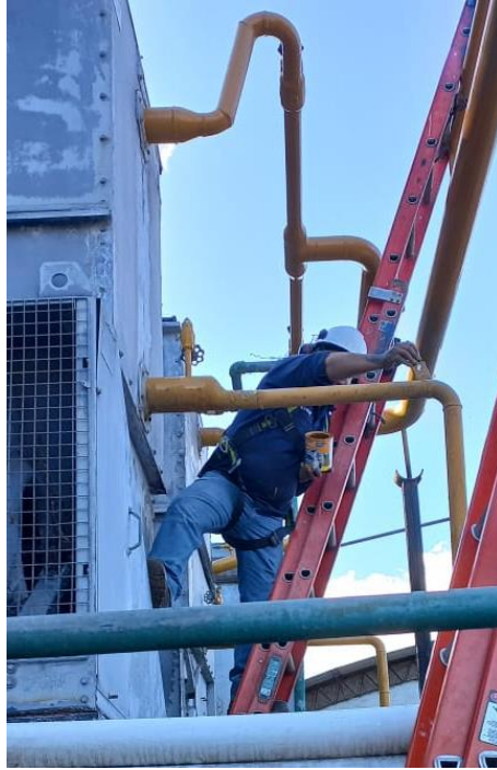
Figura 36. Mantenimiento a la tubería del sistema de refrigeración industrial
